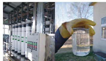
北京国际会议中心污水处理
